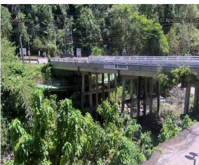
สะพานบ่อน้ำร้อน - อ.เมือง จ.ระนอง (ลุ่มน้ำภาคใต้ฝั่งตะวันตก)
